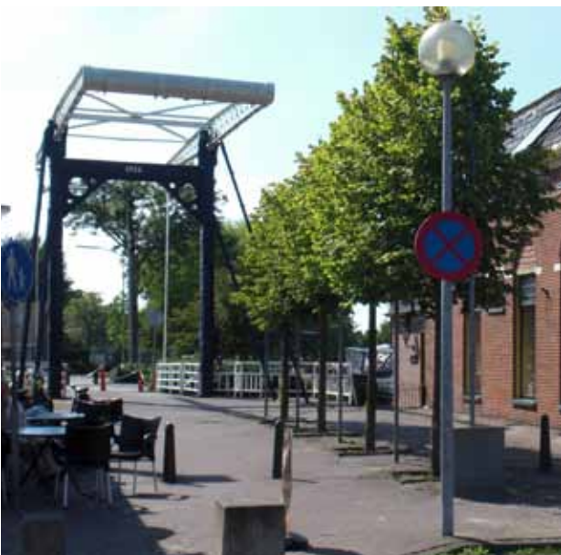
Brug over Muntendammerdiep
